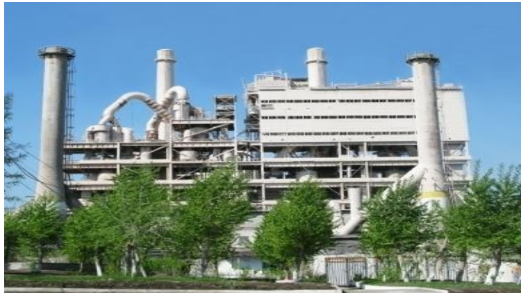
АО «Катавский цемент»
