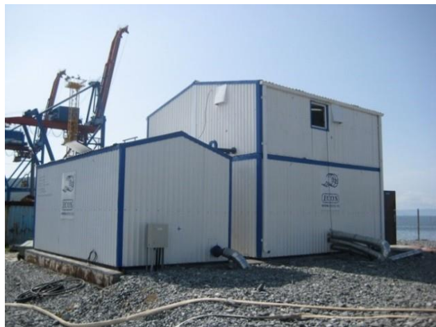
Блочно-модульная КОС закрытого типа серии ЁРШ производительностью от 100 до 1200 м³/сут.
